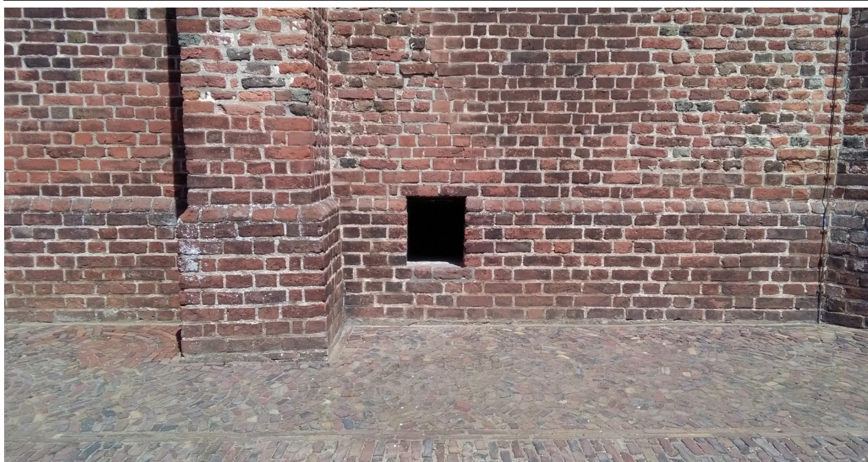
Afbeelding 3: Ventilatieopening van de Almense crypte aan de zuidzijde van de kerk.
