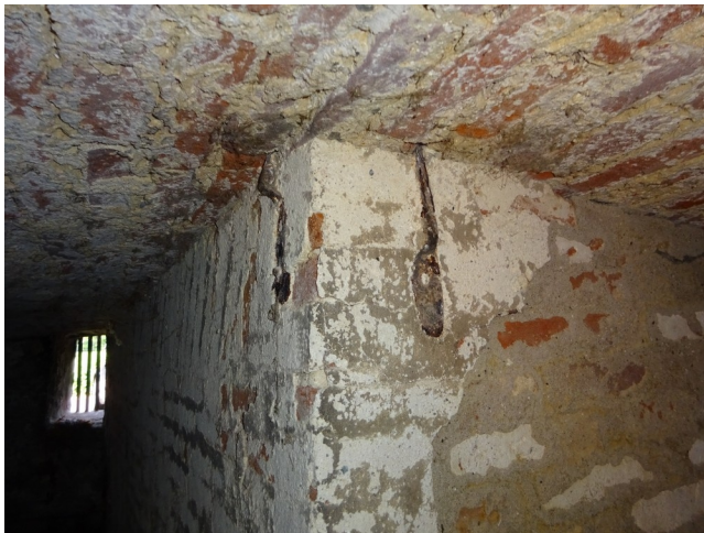
Afbeelding 14: Muurankers op de hoek van de afscheidingsmuur van de bijruimte.
