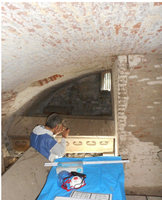
Afbeelding 11: De uitvoering van de quick scan (zicht door zuidelijke ventilatieopening).
