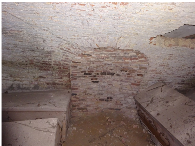
Afbeelding 12: Zicht op de westmuur van de crypte met de dichtgemetselde ingang.
