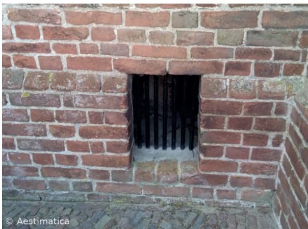
Ventilatieopening aan de noordzijde van de kerk
